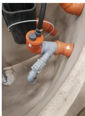
Bild 2 (insida brunn vid självfall)
