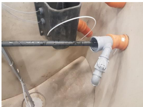
Bild 3 (insida brunn vid pumpning med bräddavlopp)
