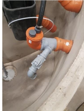
Bild 2 (inside brunn vid självfall)
