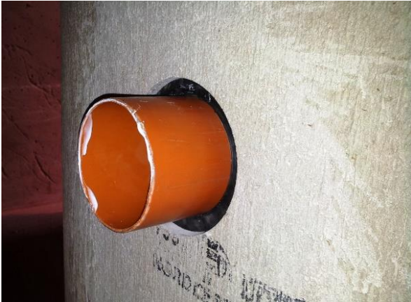
Bild 1 (utsida brunn vid självfall)
