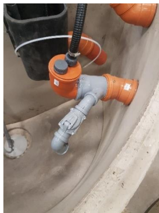
Bild 2 (insida brunn vid självfall)
