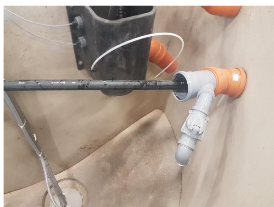
Bild 3 (insida brunn vid pumpning med bräddavlopp)
